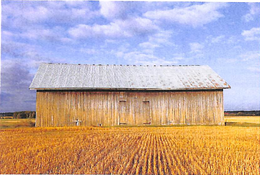
Kuva 14. Tyypillinen lietolainen peltomakasiini on suorakulmainen, lautarakenteinen varastorakennus. Kuva: Nautelankosken museon kokoelmat, NKM/va/11243:4149.
