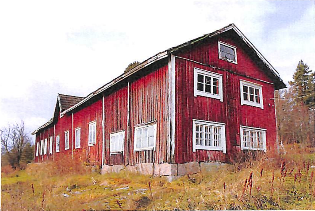
Kuva 5. Pitkänomaisen rakennuksen kuvaajan puoleisessa päädyssä on sijainnut kaksikerroksinen kanala, josta merkinä ovat nykypäivään saakka säilyneet runsaat ikkunat. Keskellä rakennusta on ollut talli- ja varastotiloja ja kauempana olevassa päädyssä sijaitsivat vuoden 2013 inventointihetkelläkin tilan vanhan isännän ja emännän asuintilat. Kuva: Nautelankosken museon kokoelmat, NKM/va/11243:7318
