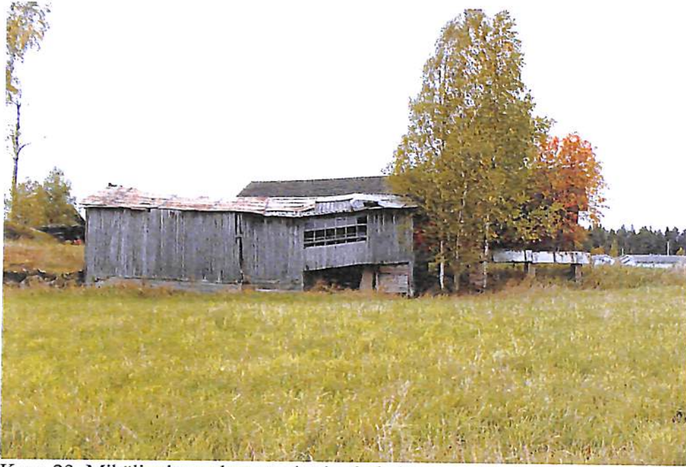
Kuva 23. Mikäli rakennuksen omistaja ei ole inventointihetkellä ollut saatavilla, rakennustyypin tuntee parhaiten sen sahalinjastosta. Kuvassa betonipaalujen varaan rakennettu linjasto tulee ulos rakennuksesta kuvan oikeassa reunassa. Kuva: Nautelankosken museon kokoelmat, NKM/va/11243:4456.
